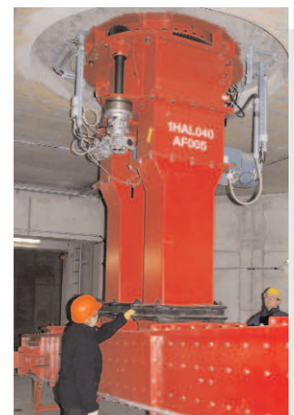
BAS 3, eingebaut in Beton-silo
