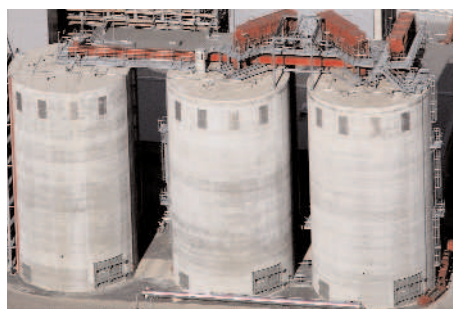
Betonsiloanlage für Holzhackschnitzel
